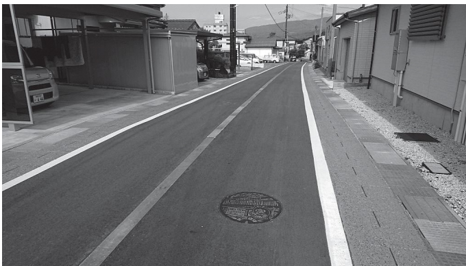
写真2 両側路側帯を石畳風に美装化(開粒度ASにセメントミルク浸透後カッター処理)・手前に復興版デザインマンホール蓋
