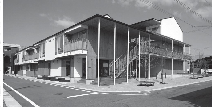
写真4 周囲の景観と耐火性能に配慮した木造住宅
