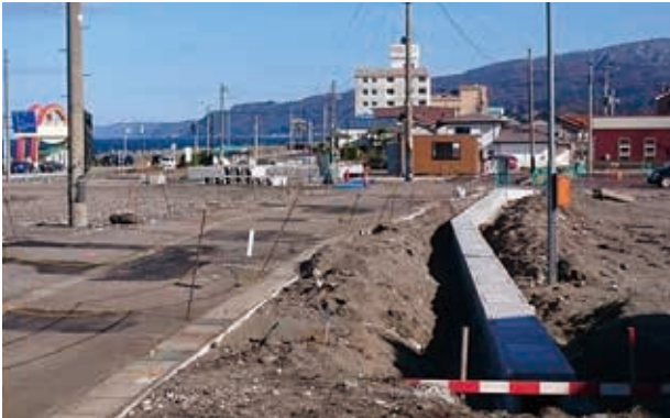
中央に拡幅前の道路側溝（12月上旬）
