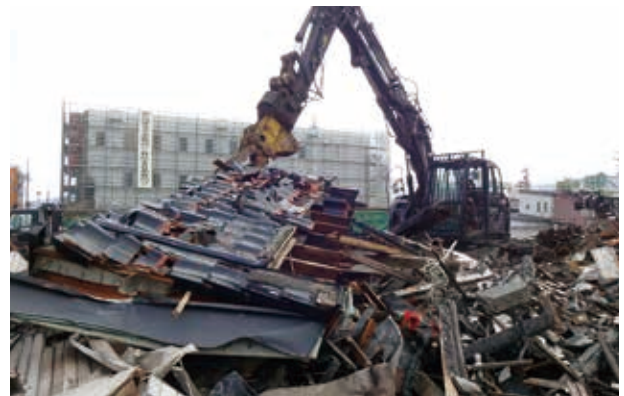
がれき撤去作業
