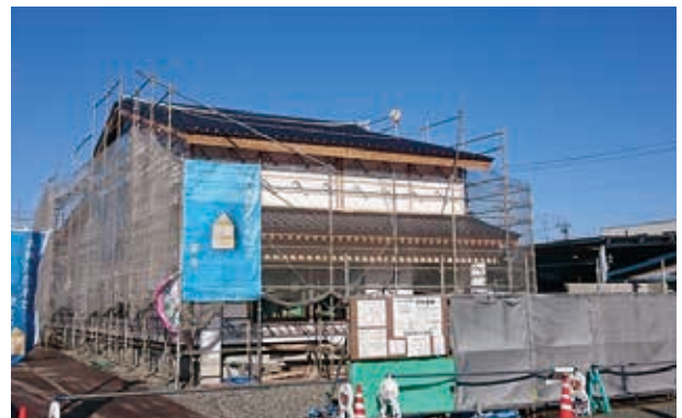
ガイドラインに基づき再建が進む建物（12月上旬）
