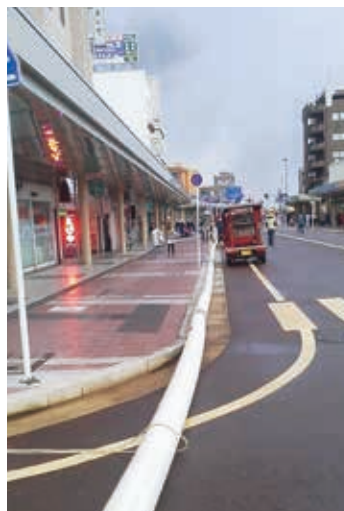
排水ポンプ車による送水
