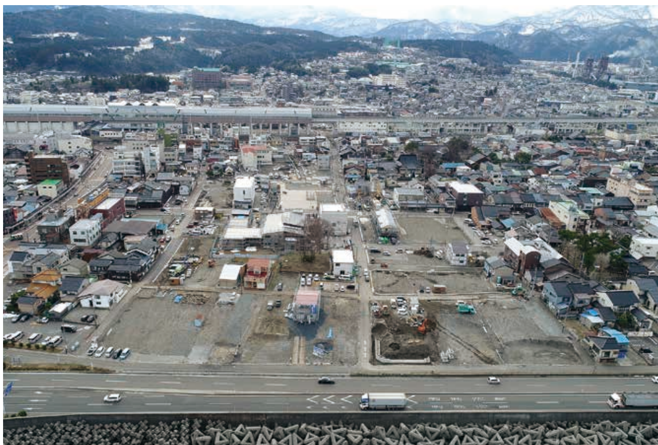
被災地北から南方向（平成29年12月22日撮影）※大火から1年
