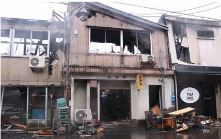
火元となったラーメン店 (12月23日)
