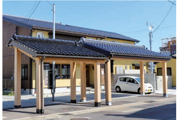
独立タイプの雁木。駐車帯を設けている(右側)
