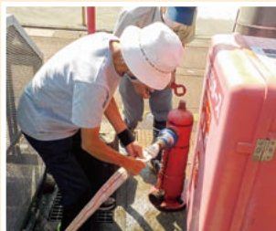
▲消火栓にホースを付けた後、接続が確実であるかを確認
