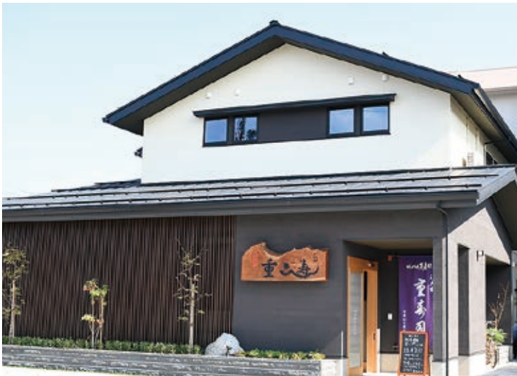
完成した新店舗
